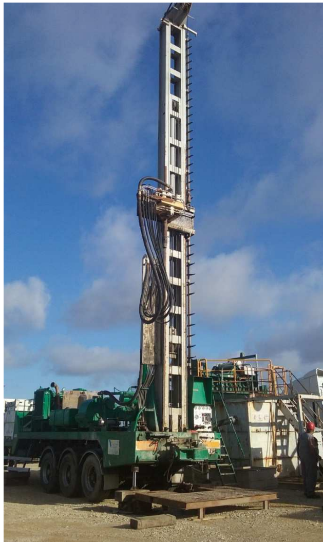
Machine de forage
